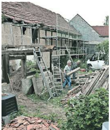
An dem historischen Wirtschaftsgebäude haben Sicherungsarbeiten begonnen. FOTO: BECKMANN
